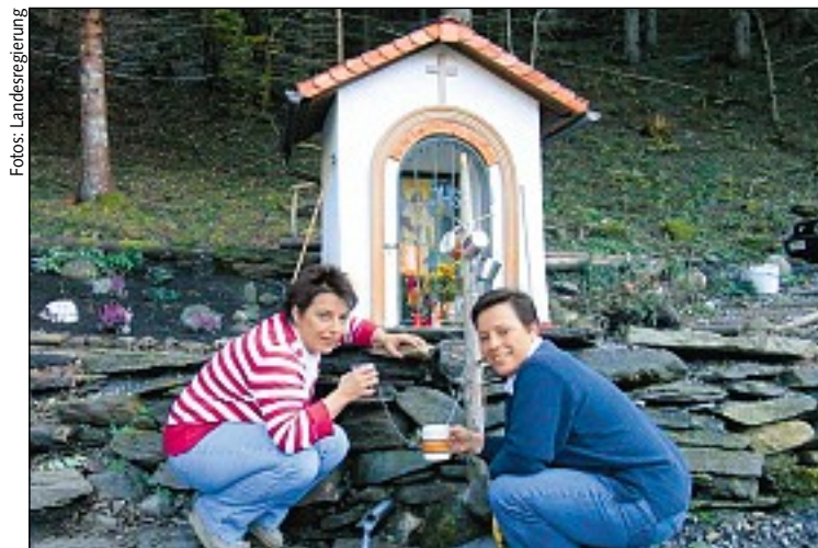
Arbeit an der Quelfassung bei der Erasmuskapelle in Kolbnitz
